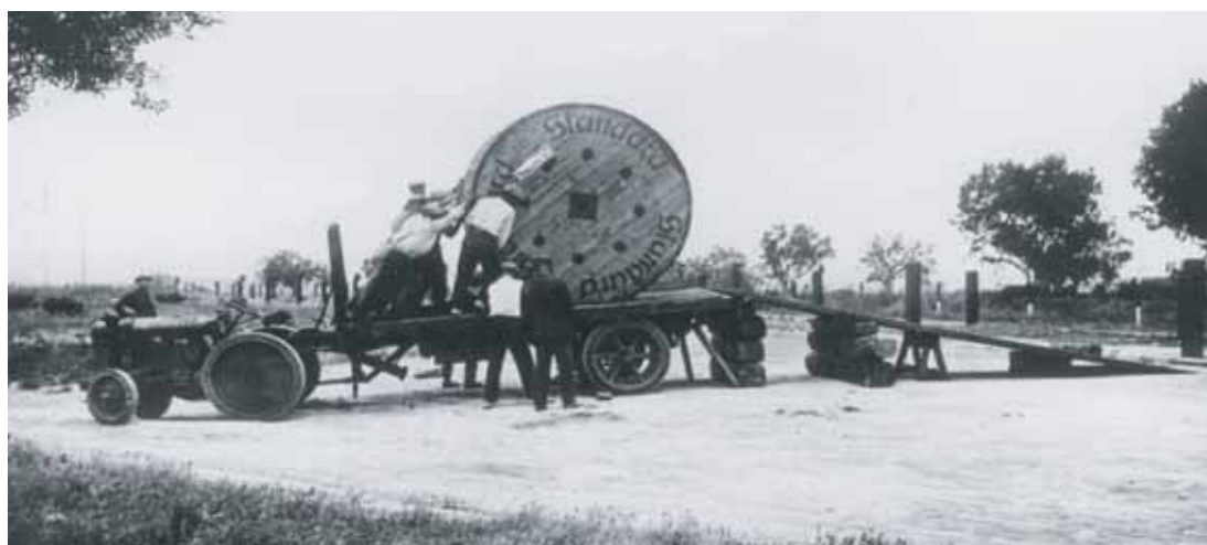
Instalación de la línea Barcelona-Vall (1929). A partir de 1926, con la llegada del teléfono automático, se precisa de una infraestructura amplia y compleja. Se realiza un vigoroso esfuerzo de expansión del servicio y modernización de las infraestructuras. El desarrollo de la red interurbana requirió tender muchos kilómetros de cables en un corto espacio de tiempo
