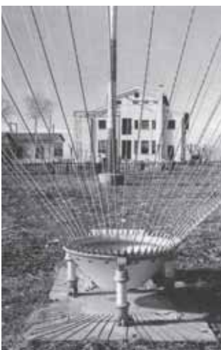
Antena de estación de radio para comunicaciones transatlánticas en Pozuelo del Rey, Madrid
